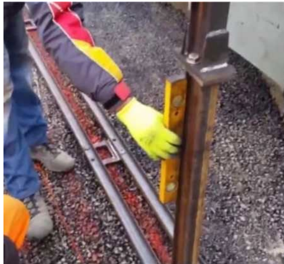
Fig. 10: Sjekk med et vater
