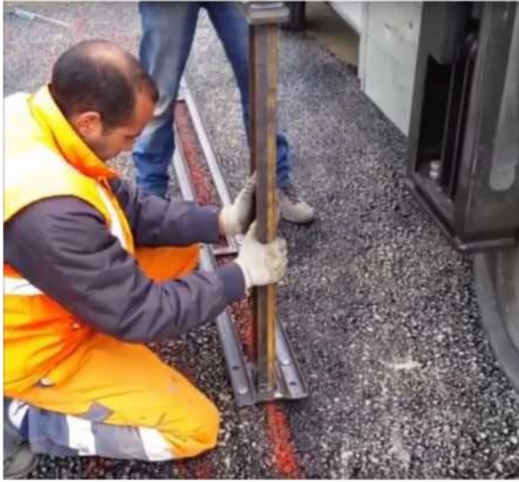
Fig. 8: Montering av stolpetype IPE 80 med sveiset plate.
