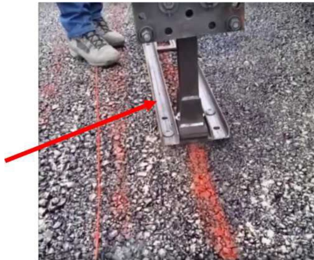
Fig. 11: Nedhamringen av stolpen er fullført
