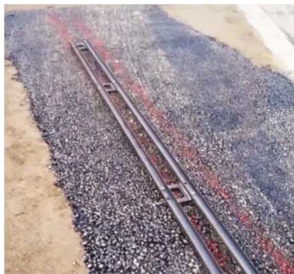
Fig. 7: Forberedelse av monteringsplatene ved å bruke boremalen for SMA T2–SMA T4
